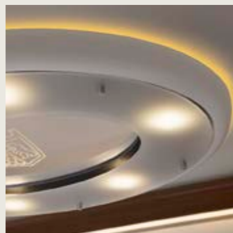
Een slim uitgewerkt concept verbindt de plafondverlichting met een rookglazen ring en embleem met dimbare sfeerverlichting.
